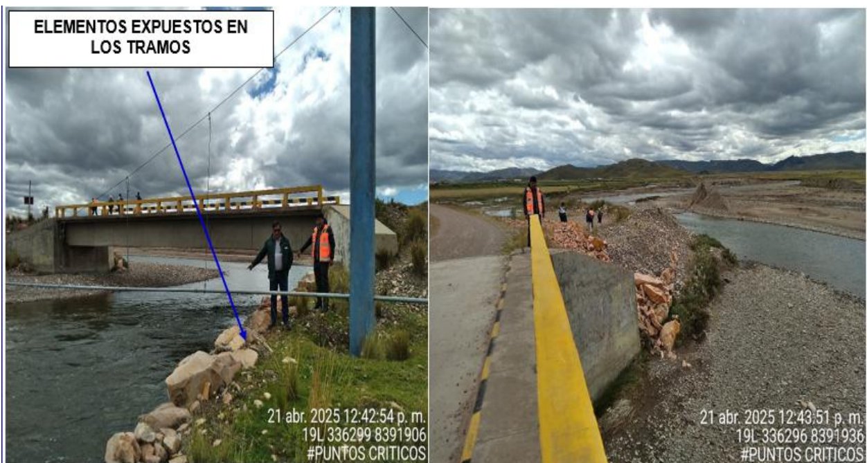
FIGURA N°02: FIGURA N°02: LA PRINCIPAL VIA EXISTENTE Y PROPENSAS ANTE UNA CRECIDA DEL RÍO JORAHUIÑA Y LA EROSION EN LA MARGEN DERECHA.
